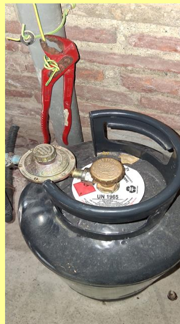
Gasflasche auf: Rechtes Rädchen nach links drehen
