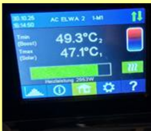
Einstellung Temperatur Warmwasser am Heizstab
